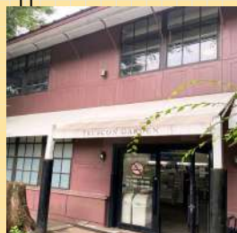
学生の憩いの場「トラスコンガーデン」鉄骨造りの躯体・屋根・外壁などがトラスコンステールカンパニー社（米）より輸入されたことに由来
